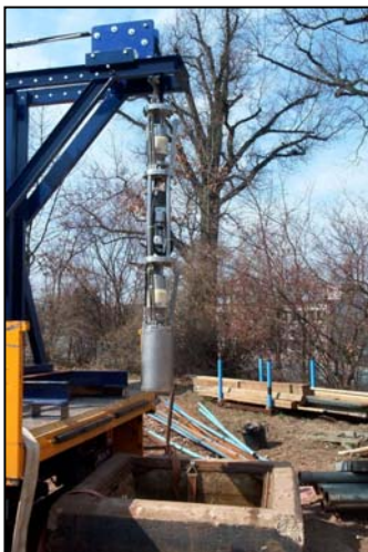
Einbringen des Manipulators
