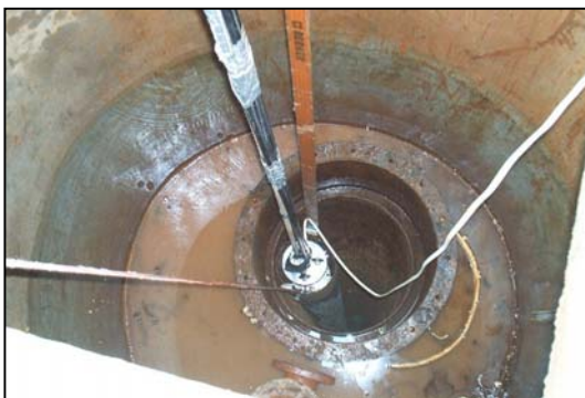
Eintauchen des Manipulators in das Brunnenrohr
