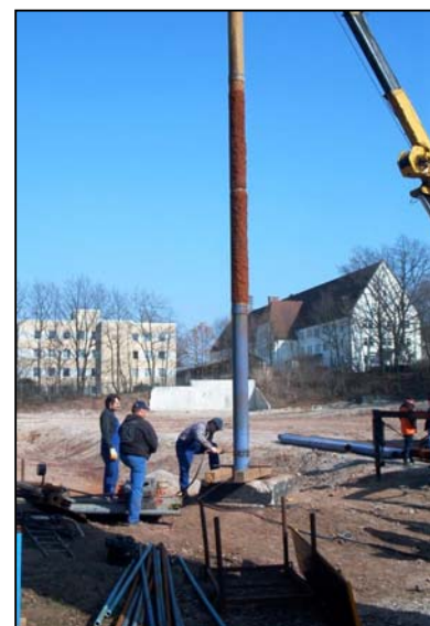
Ziehen des abgetrennten Rohres nach dem Schnitt
