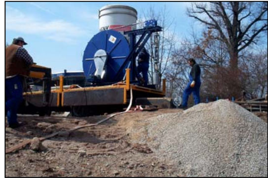
Einsatz auf der Baustelle
