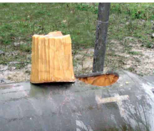
Zugangsschnitte (im Sprengsatz)
