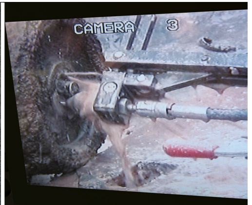
Videüberwachung des Schneidvorgangs
